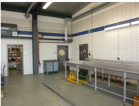
Waschhalle inkl. Schlauchpflegeanlage
